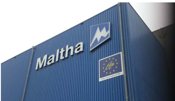
Silogebouw voor opslag gebroken glasscherven
